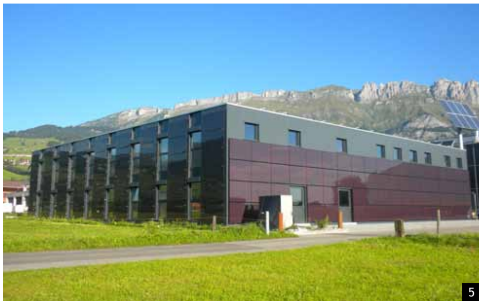
Abb.5: Dieser solare PlusEnergieBau (PEB) weist eine Eigenenergieversorgung von 448% auf und gewann den Schweizer und Europäischen Solarpreis 2011.
