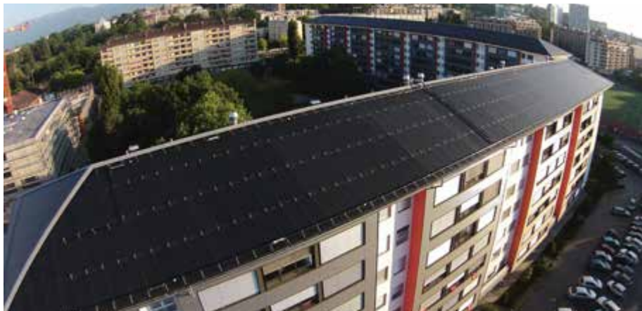
Der Energiebedarf dieser Minergie-P-Sanierung reduzierte sich um 90% von 5,5 auf 0,5 GWh/a. (© SAS)
