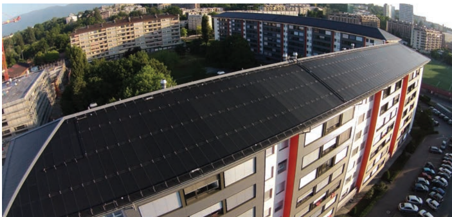
Der Energiebedarf dieser Minergie-P-Sanierung reduzierte sich um 90% von 5,5 auf 0,5 GWh/a. (© SAS)
